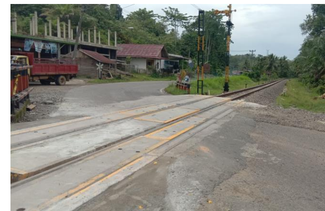
Jalur Lintas di Bungamas (Sumatera Selatan )
